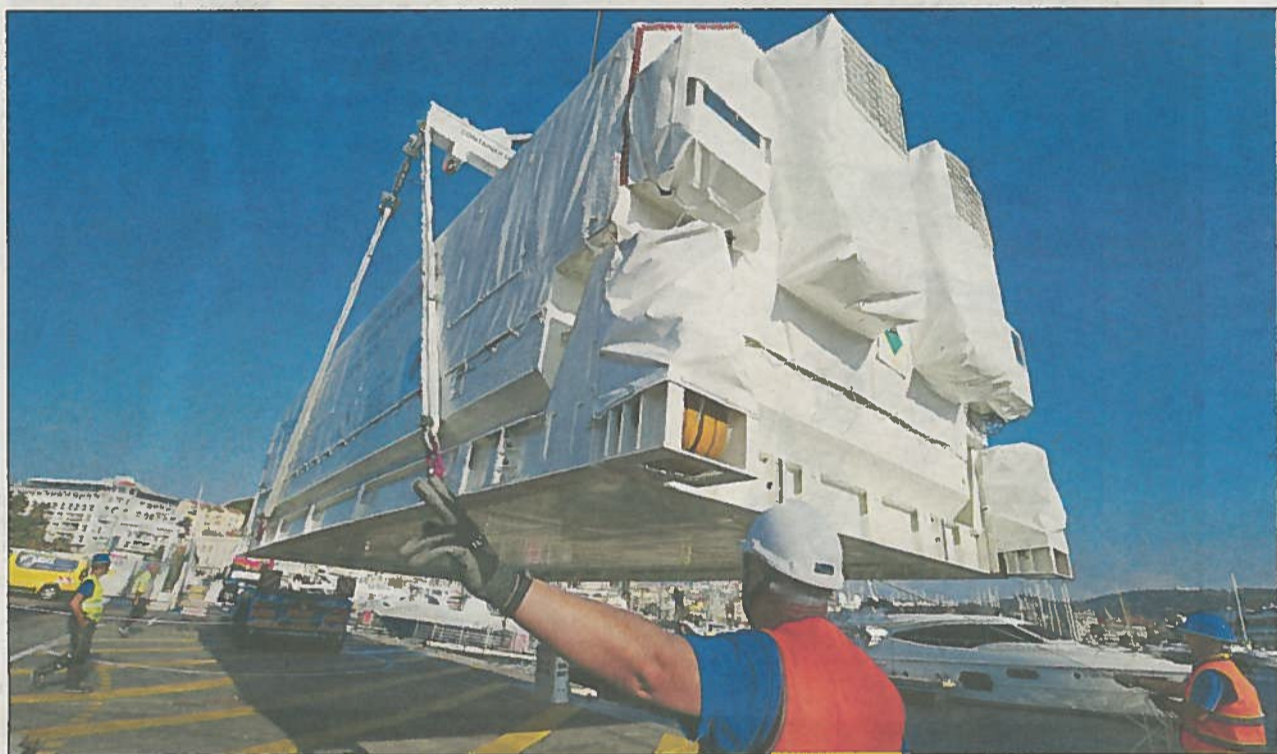
Impressionnante manœuvre que le levage du précieux conteneur à 1,5 M€...
